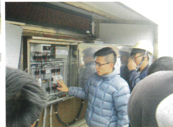
太陽光電設置乙級技能檢定練習
