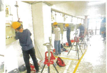
室內配線丙級技能檢定練習
