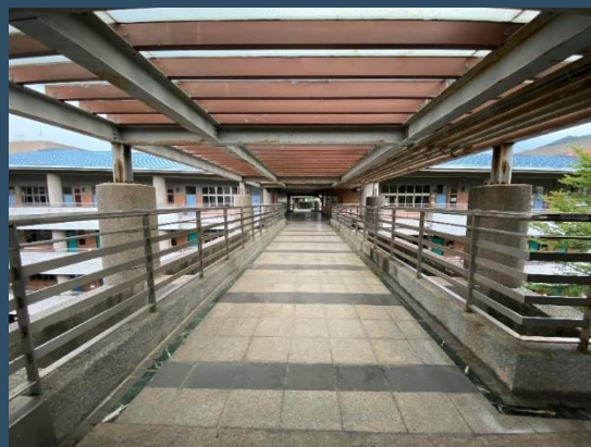
安全防護 裝設符合規範的欄杆
